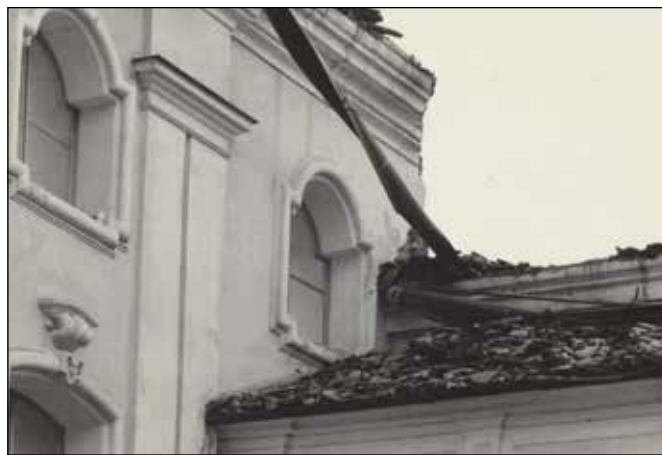
Jižní průčelí schodišťového rizalitu, 1964, sbírka Národního památkového ústavu, ú. o. p. v Ostravě.
