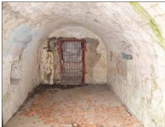
Současný vzhled interiéru Skalního sklepa.
