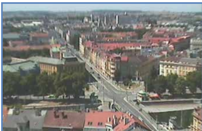
Střechy domů dosahují teploty až 63°C, povrch aleje stromů 35°C
