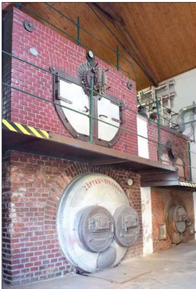
Původní parní kotel typu Tischbein z roku 1893 na tuhá paliva. Továrna se jím vytápěla ještě ve 2. pol. 20. stol., když v ní byl velkosklad textilu.
