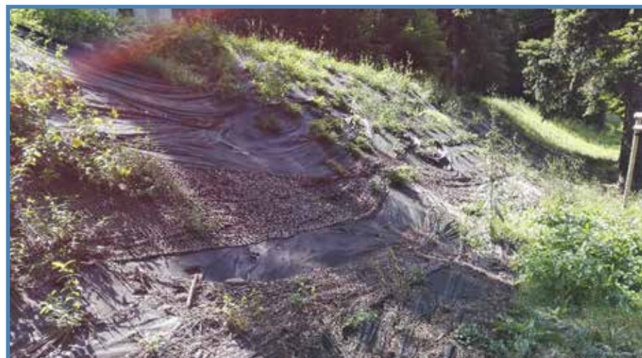
Poškozené výsadby v Parku osvobození
