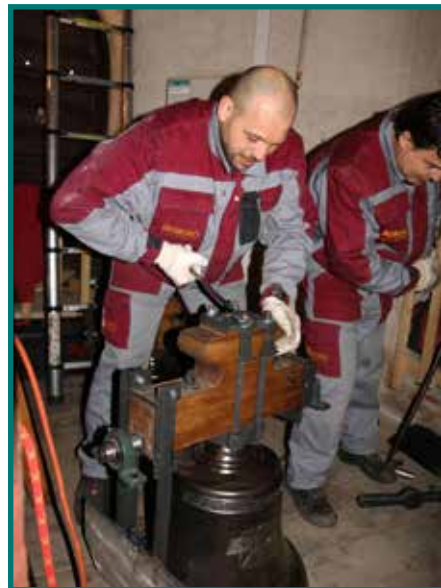
Přípevnění závěsu zvonu
