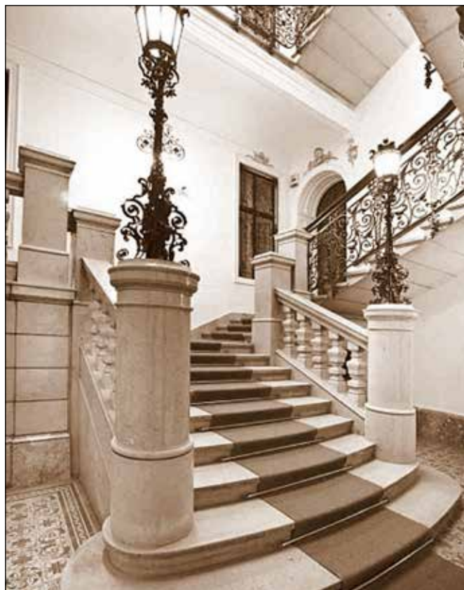
Schodiště obytného domu Herzmanských na Lindengasse № 10. www.jpi.at
