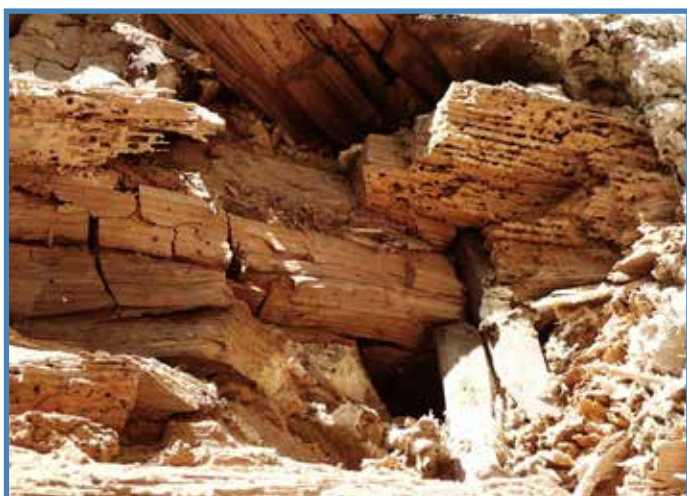
Napadení dřevokazným hmyzem a houbami
