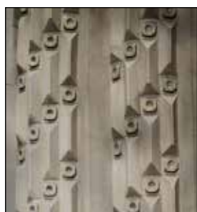
Výzdoba archivolt (průčelí) ústupkového vstupního portálu.
