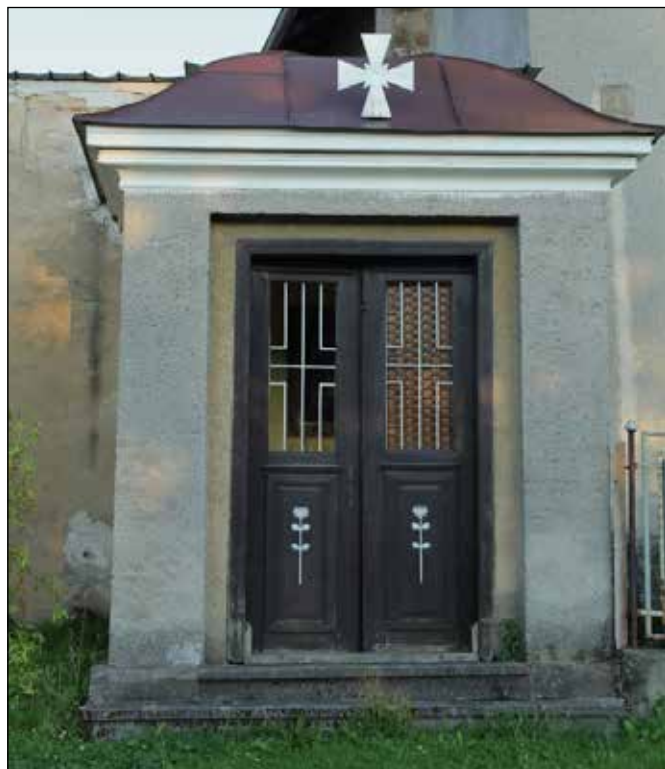
Božítelová kaplička v průčelí jednoho ze statků.
