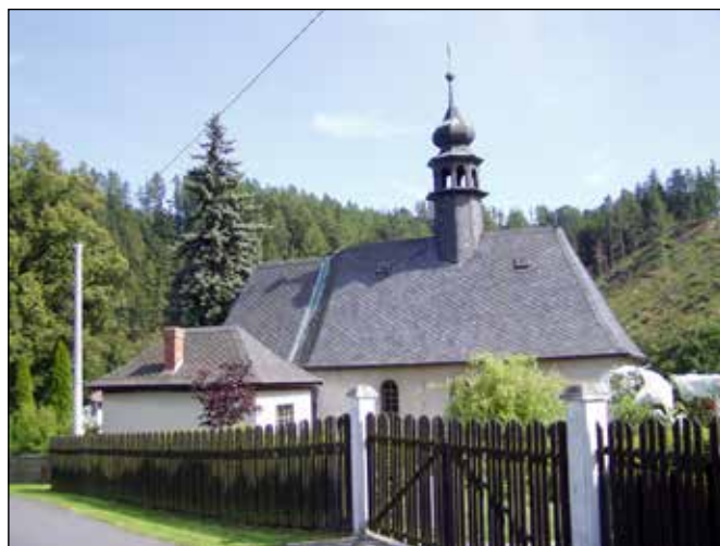
Břídlíkové střechy kostela sv. Petra a Pavla v Kružberku.
