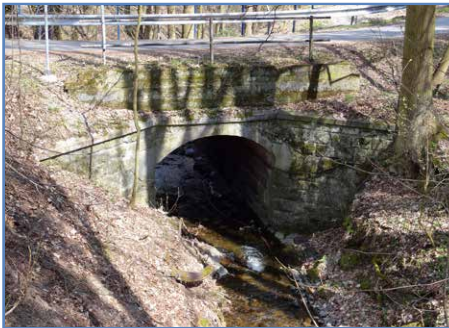
Propustek u skalních sklepů
