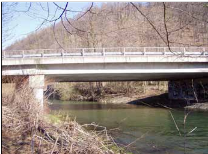
Železobetonový silniční mankovický most v současnosti.
