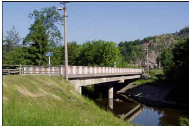
Železobetonový silniční most v Jakubčovicích n. O. v současnosti.
