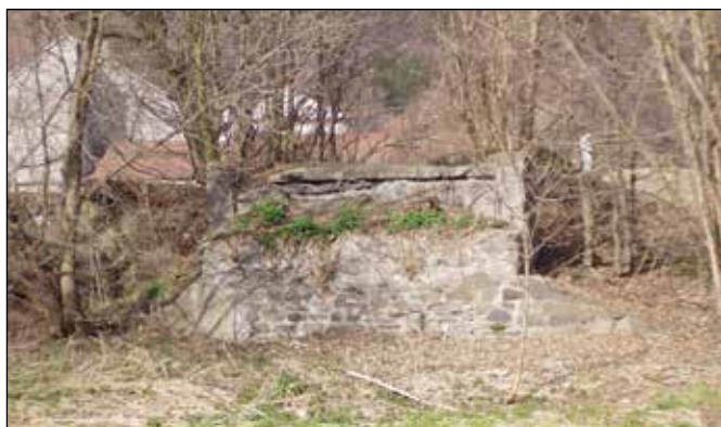
Základy zaniklého dřevěného krytého mostu v Heřmánkách.
