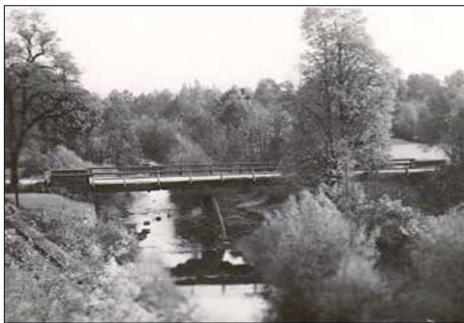
Původní mankovický most mezi světovými válkami.
