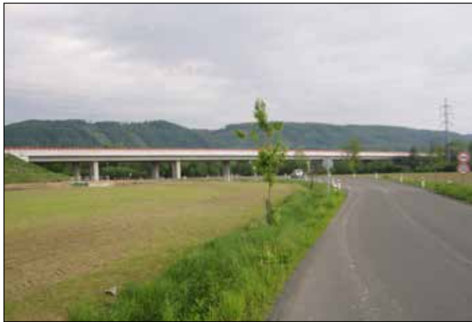
Dálniční estakáda v Mankovicích.
