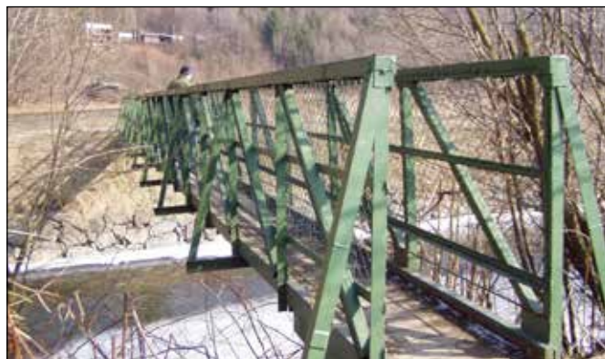
Nová pěší příhradová lávka v Loučkách u chat.
