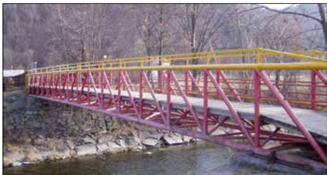
Ocelová příhradová lávka v Jakubčovicích n. O. v současnosti.
