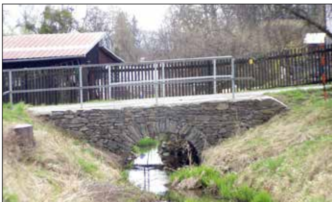
Kamenný propustek u vodního mlýna v Loučkách.
