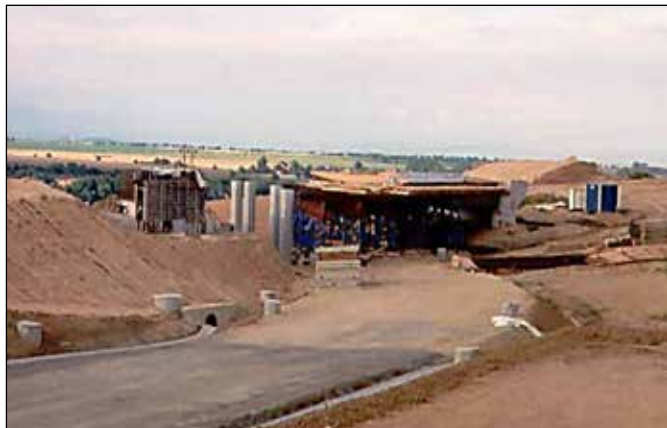
Příprava betonáže mostovky mostu převádějící hlavní trasu D1 přes větev R46 ve směru Brno – Olomouc. Vpravo D1 směr Kroměříž, pod most směřuje R46 ve směru na Olomouc.
