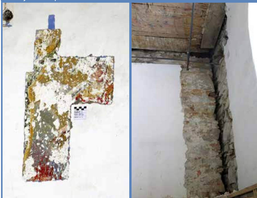
Barokní malby na vnitřní omítce.
