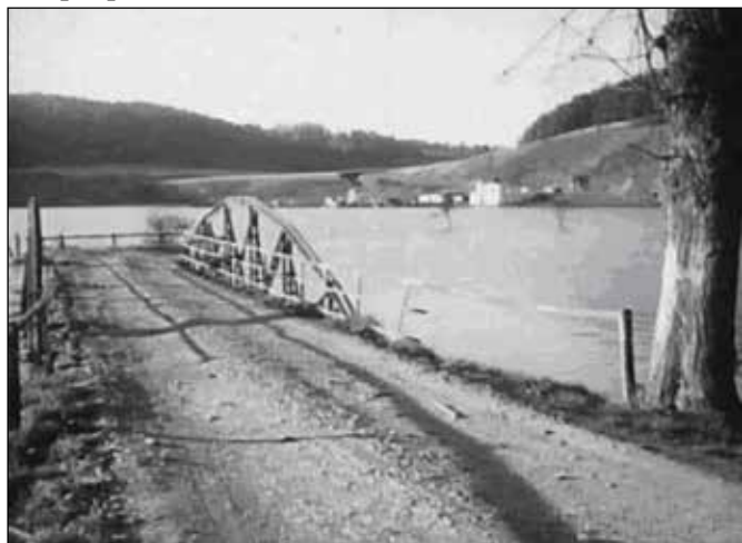
Ocelový most na původním místě v údolí Moravice při výstavbě přehrad, Zdroj: Historický dokument. film z výstavby Kružberské přehrady.
