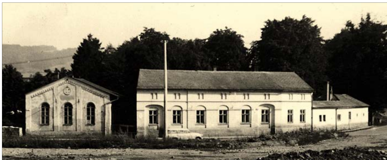
Odry, budovy bývalé Střelnice (D), v současnosti autobusové nádraží.
