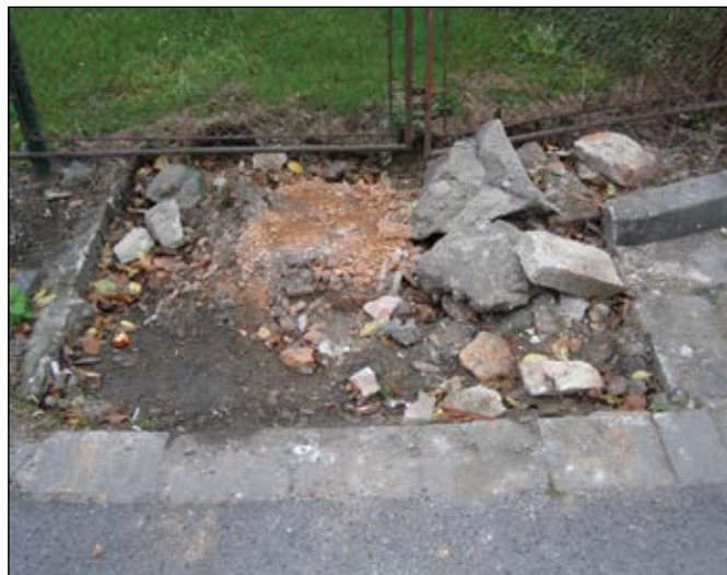
Základ kříže po jeho demontáži 30.11.2013
