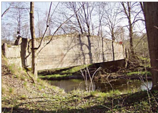
1 Železobetonový most u Nových Oldřůvek
