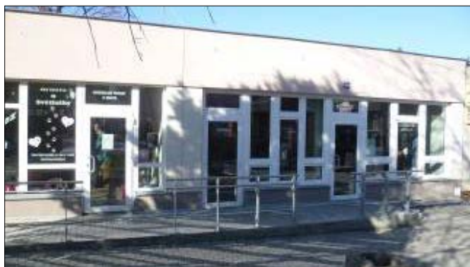
Rekonstrukce veřejného WC a čekárny na autobusovém nádraží
