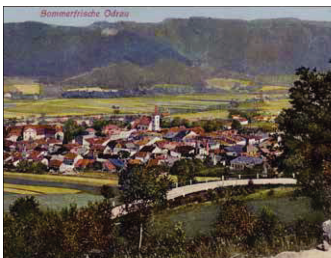
24 Dobešovská cesta, 3. serpentina, pohled na Odry se zámek
