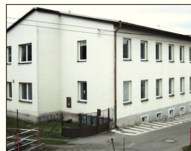
Budova C , Slunečná 2
