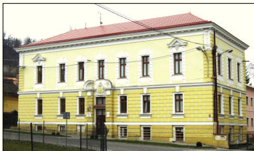
Budova A , Sokolovská 2
