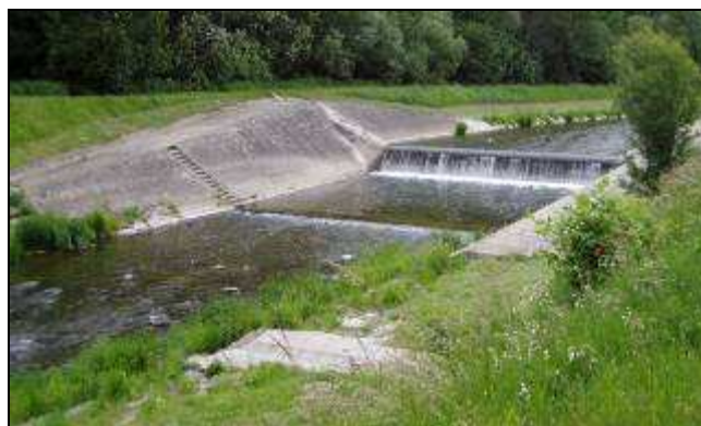
Odry v místě plánovaného zaústění koryta Vítovky
