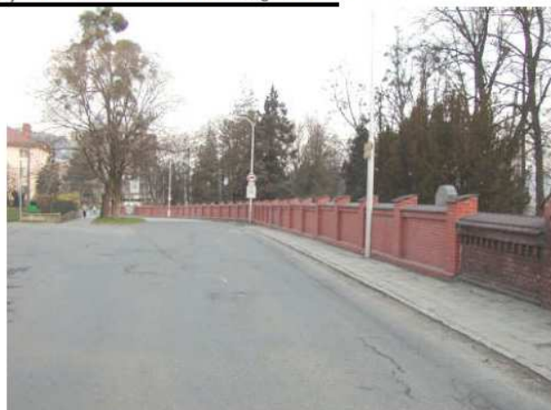
Oprava hřbitovní zdi
