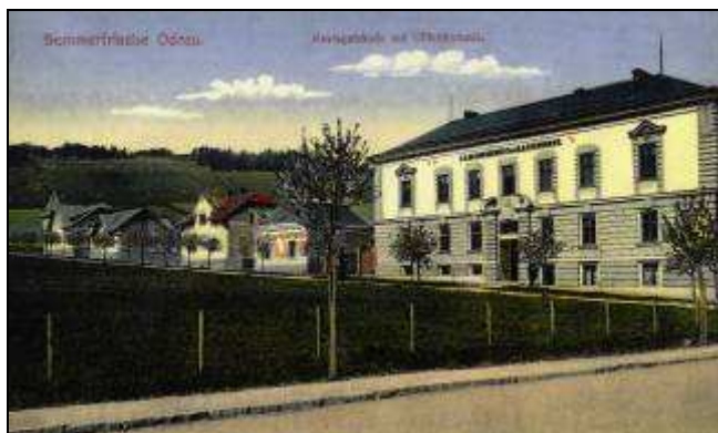
Foto - Budova bývalého soudu, dnes Střední škola, Sokolovská 2
