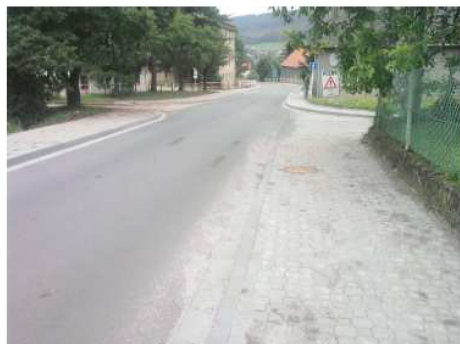
Oprava chodníku ul. Potoční, Odrá
