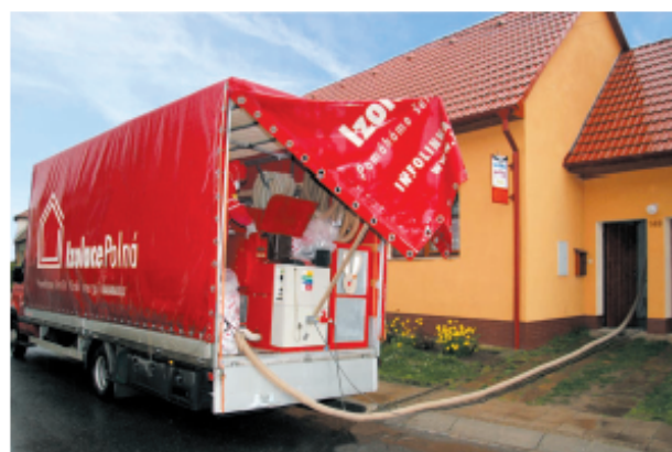
Foukání izolace hadicí z vozu před domem
