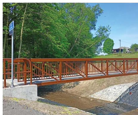
Lávka přes Dolní Datyňku
