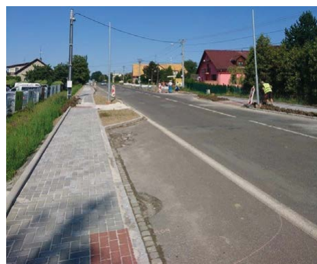
Oprava chodníku směr Havířov
