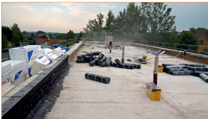
MŠ Lapačka – oprava střechy
