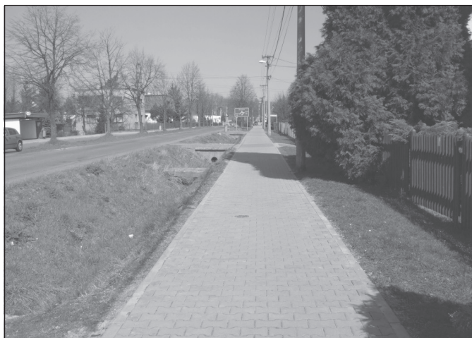
...a po opravě
