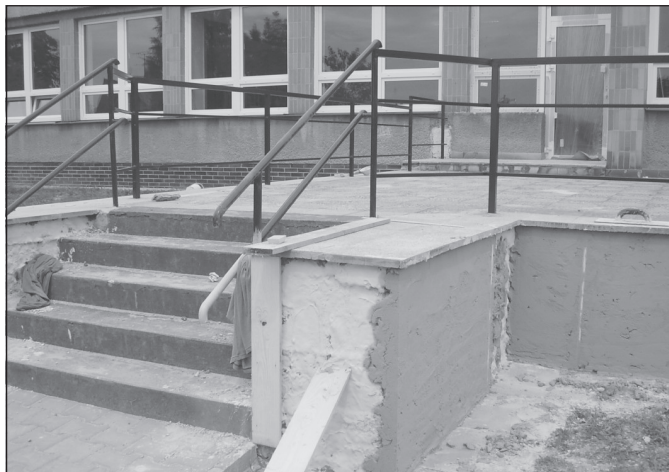
Opravy teras v mateřské škole
