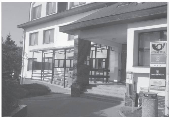
Nájezdová rampa do budovy MěÚ
