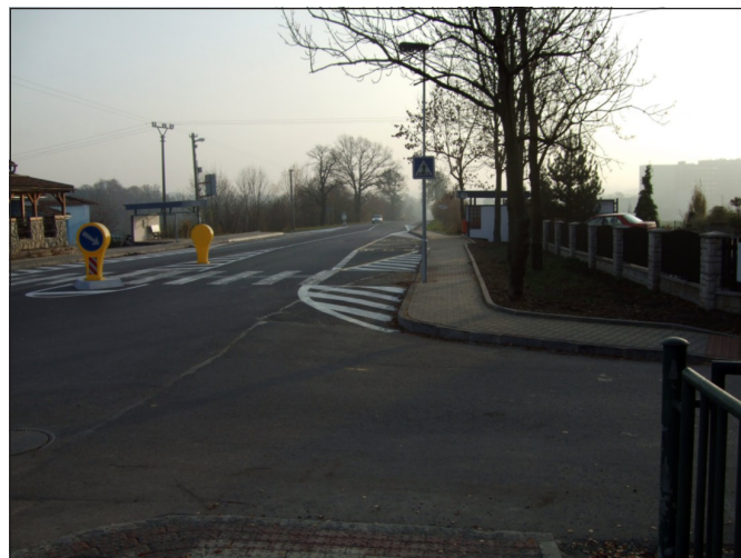
A takto vypadá nový přechod a chodníky ve stejném místě nyní.
