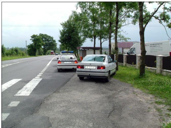
Stav přechodu u zastávek autobusů vedle školy na Podlesí před zahájením rekonstrukce.
