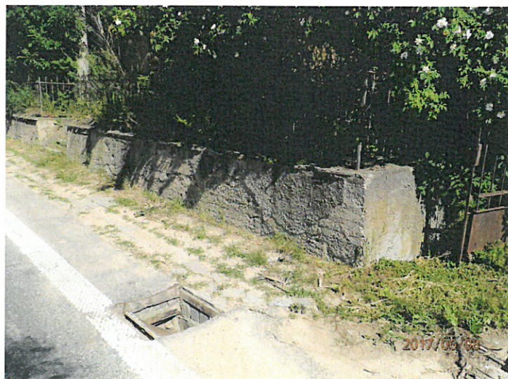
rok 2018 Oprava chodníků Deštné před
