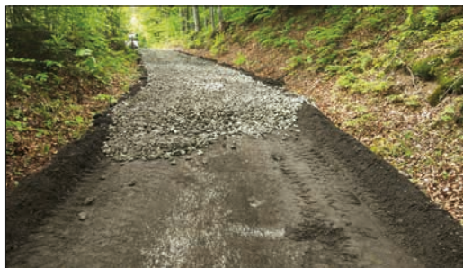
Oprava MK 69c technologií KAPS-LE
