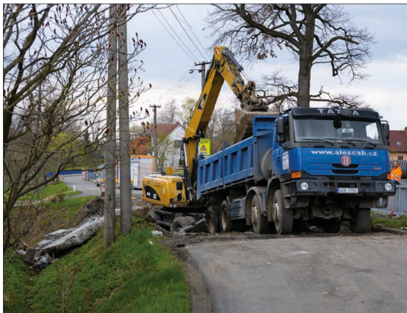
Opravu mostu přes silnici III/48310 realizuje Správa silnic MSK
