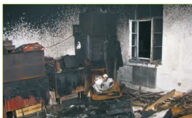
I takto může vypadat byt po požáru od zapnutého elektrického spotřebiče ponechaného bez dozoru.
