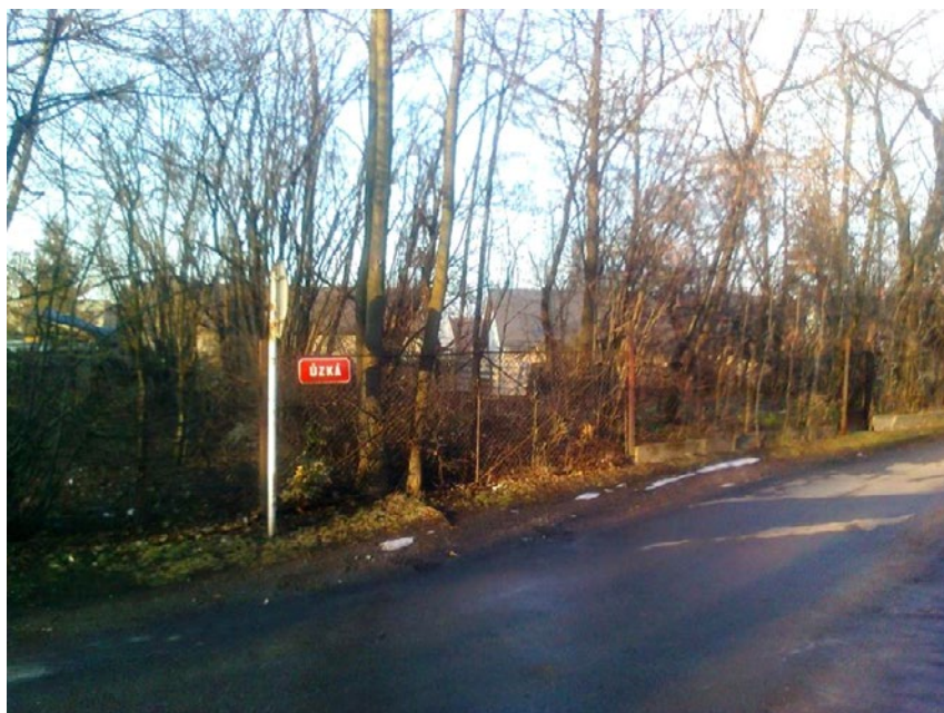
Pohled na zbořeníště, kde původně dům č. 23 ve Sviadnově stál. Foto z roku 2018.
