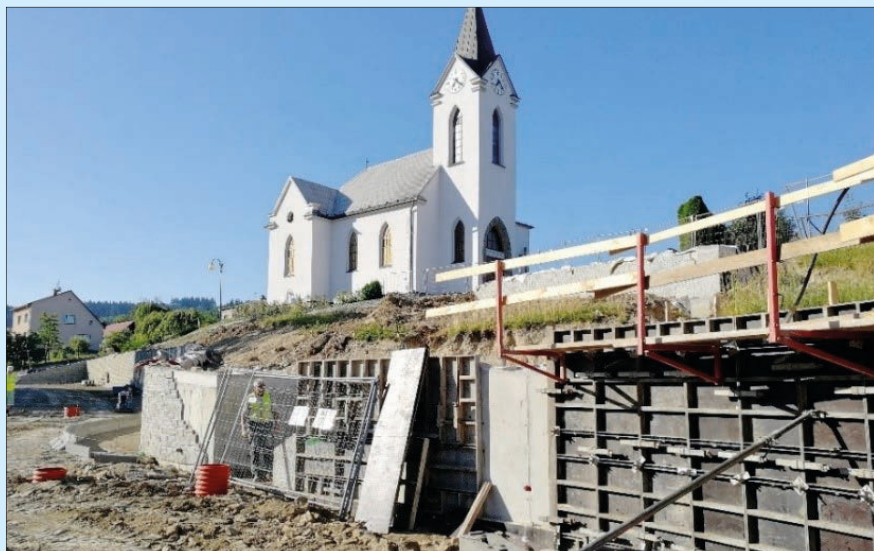
VÝSTAVBA PARKOVIŠTĚ U KOSTELA - Betonáž opěrné zdi
