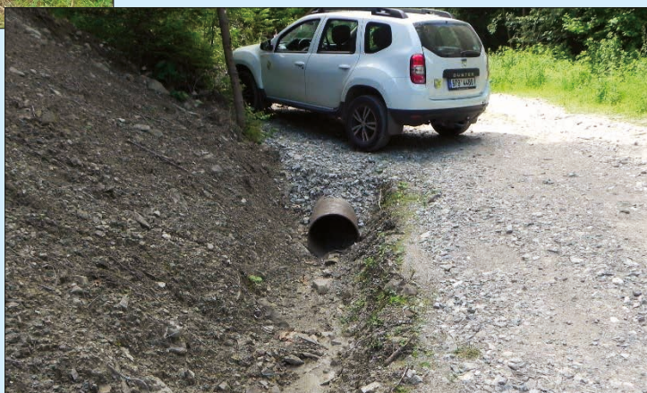
Čištění kanalizačních vpustí a příkopů
