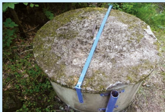
Údržba studní včetně zabezpečení před poškozením
