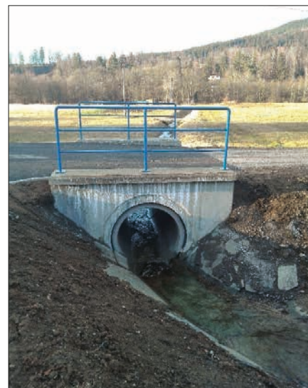
Po realizaci prací
