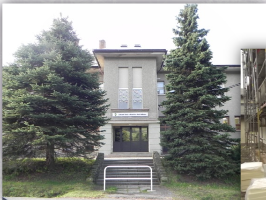
během rekonstrukce, říjen, tepelná izolace →
