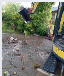
NÝDEK - ODMIAREK Ucpaný propustek pod vjezdem k rodinnému domu.
