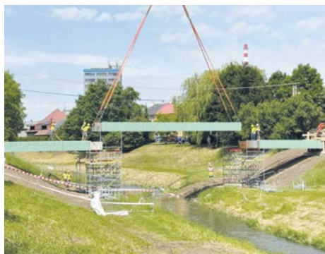
■ Dokončují se práce na lávce Novosady.
