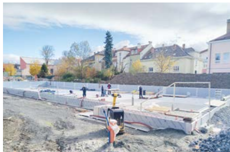
■ Probíhající rekonstrukce venkovního bazénu.
