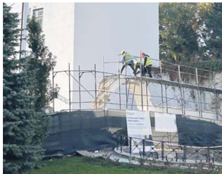
■ Začala oprava zdi Žerotínského zámku.
