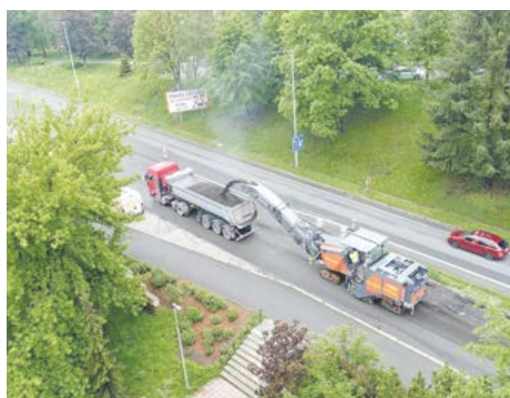
■ Začala oprava vozovky na ulici Zborovské.
