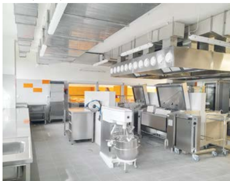
■ Kuchyně a jídelna na Dlouhé po rekonstrukci.
