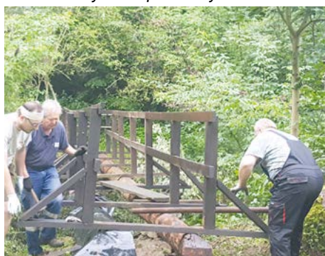
■ Studánková lávka na Putníku prošla obnovou.
