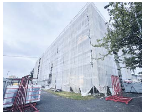
■ Rekonstrukce bývalé budovy technických služeb.
