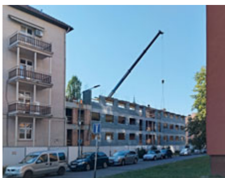
■ Rozsáhlá rekonstrukce Domova Duha.
