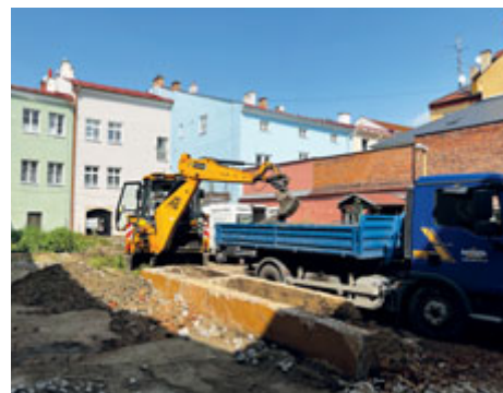
■ Začala revitalizace Laudonova nádvoří.
