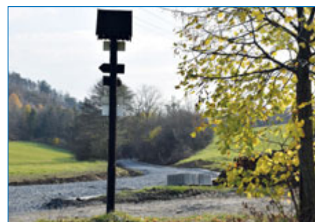
■ Oprava silnice mezi Kojetínem a Straníkem.
