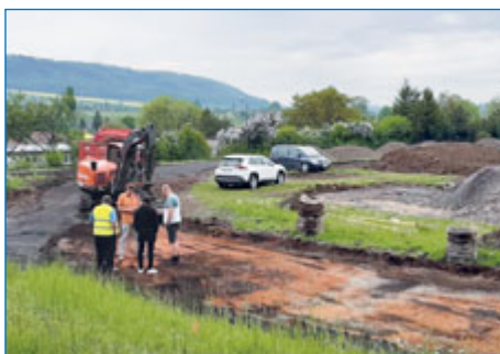
■ Začala rekonstrukce hřiště na Dlouhé ulici.
