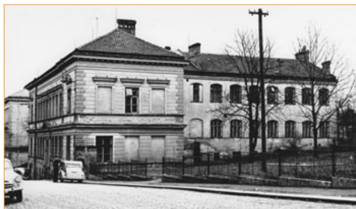
Budova bývalé tkalcovské školy, později sídlo městského archivu v Novém Jičíně. Zdroj: SOkA Nový Jičín
