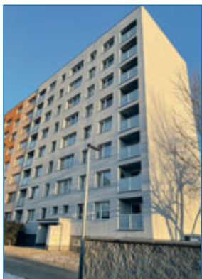
Bytový dům Na Lani po revitalizaci. Foto: Pavel Hurta
