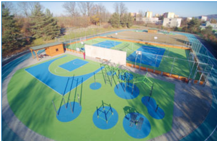
Rekonstruované hřiště na ulici Dlouhá.
