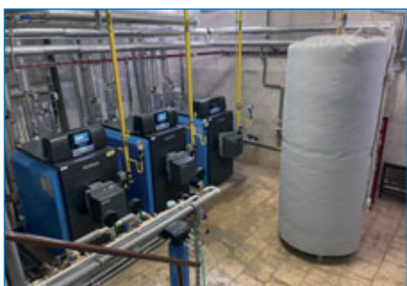
■ Modernizace kotelny Trlicova.
