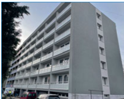
Bytový dům po rekonstrukci a zateplení pláště. Foto: Pavel Hurta
