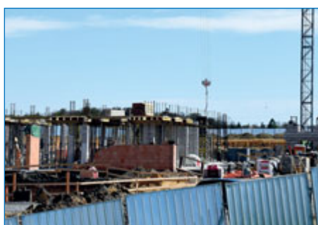
■ Pokračuje stavba nového hasičského centra.
