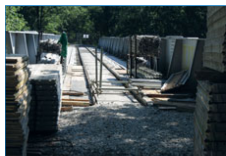
■ Rekonstrukce viaduktu rozvine cyklostezku Koleč.
