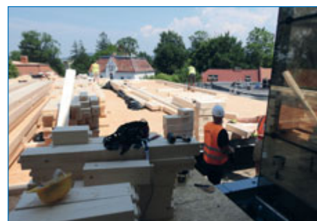
■ Na střeše Fokusu vzniká nová nástavba.
