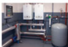
PLYNOVÁ KOTELNA S KONDENZAČNÍMI KOTLI V KASKÁDĚ teplo za 320 Kč/GJ
