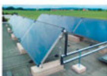
PLYNOVÁ KOTELNA SE SOLÁRNÍM OHŘEVEM VODY teplo za 270 Kč/GJ
