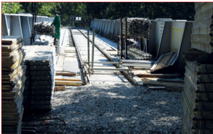
Rekonstrukce železničního mostu v Bludovicích, přes který povede odbočka cyklostezky. Foto: Marie Machková
