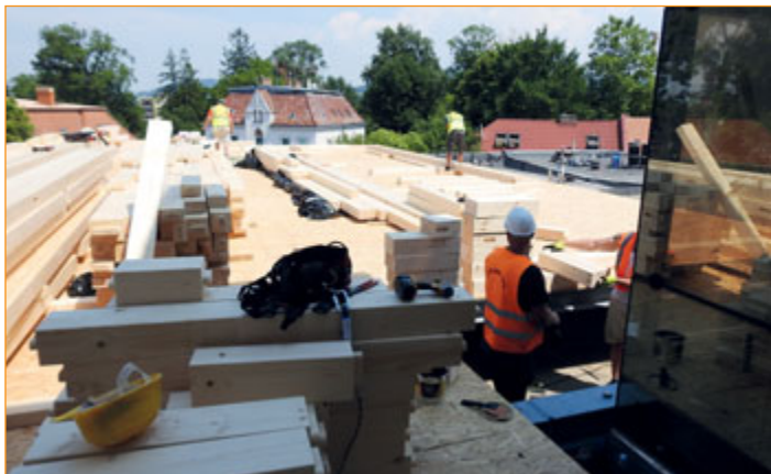
Na části střechy Fokusu vzniká dřevěná nástavba. Foto: Marie Machková
