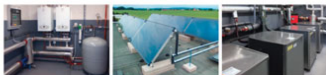
PLYNOVÁ KOTELNA S KONDENZAČNÍMI KOTLY V KASKÁDĚ teplo za 320 Kč/GJ PLYNOVÁ KOTELNA SE SOLÁRNÍM OHŘEVEM VODY teplo za 270 Kč/GJ TEPELNÁ ČERPADLA VZDUCH/VODA teplo za 290 Kč/GJ
