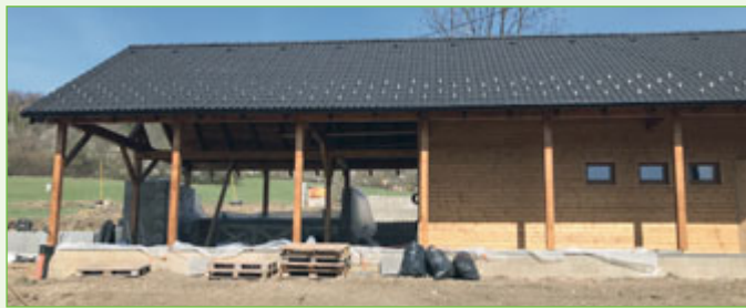
Stavba nového kiosku na Čertáku.
