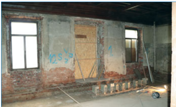
Demontované obložení původní jídelny s výjimkou kazetového stropu ve vile Augusta Hückela s pracující ozařovací technikou.
