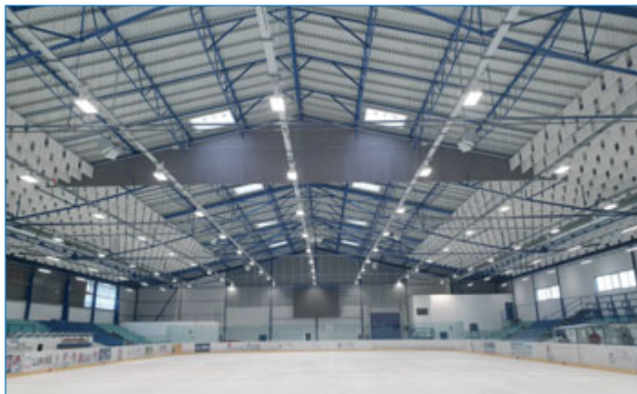
Vnitřní pohled na novou střechu zimního stadionu.
