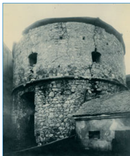
Žerotínská věž, která byla součástí městského opevnění.
