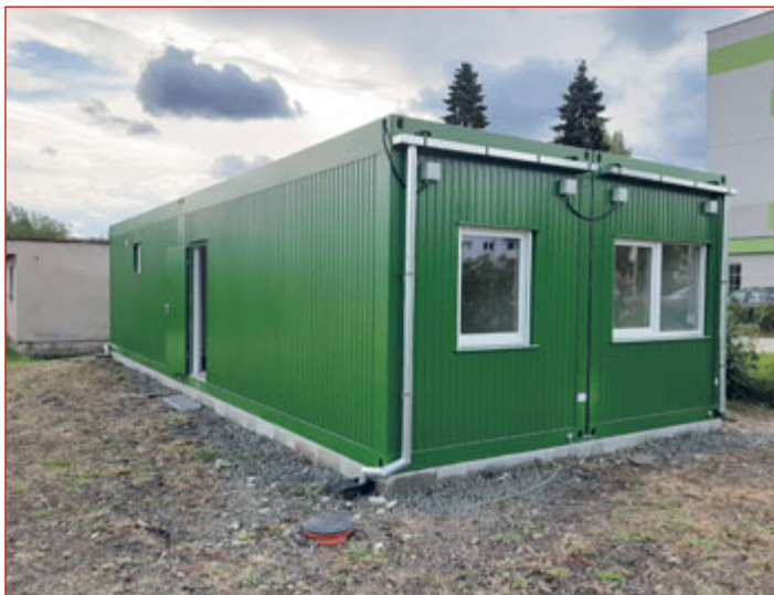
Montovaný objekt z unimobuněk je zázemím pro pracovníky střediska zeleně na Palackého ulici. Foto: Pavel Tichý
