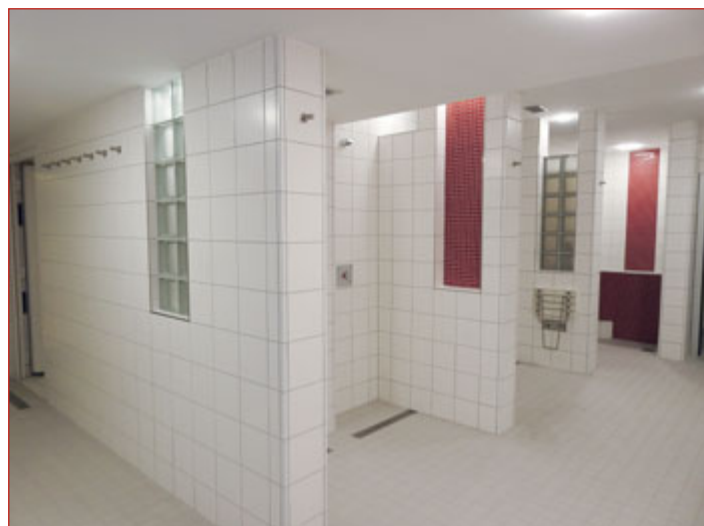
Sprchy krytého bazénu před a po rekonstrukci.
