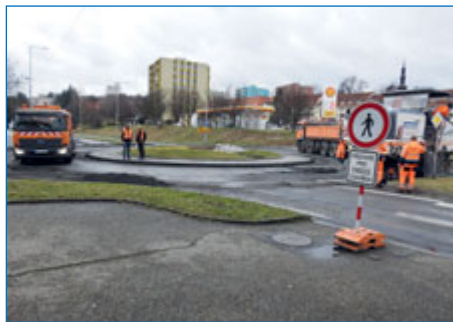
■ Rekonstrukce pěti okružních křižovatek.
