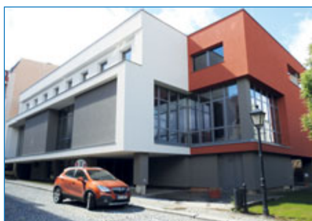
■ Přístavba Hotelu Praha s novým pláštěm.
