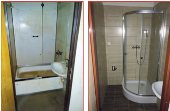
Koupelna v městském bytě před rekonstrukcí (vlevo) a po ní.
