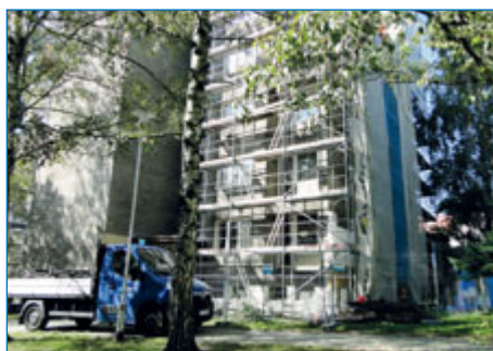
■ Zateplování bytových domů v Luční ulici.
