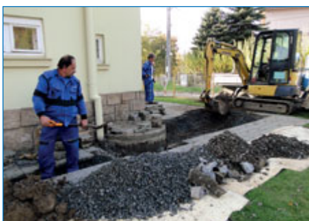
■ Nová kanalizace pro školku Trojlístek.
