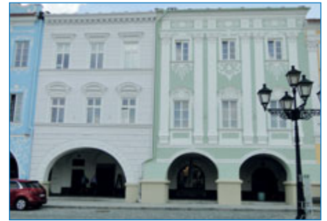
■ Oprava domů na Masarykově náměstí.
